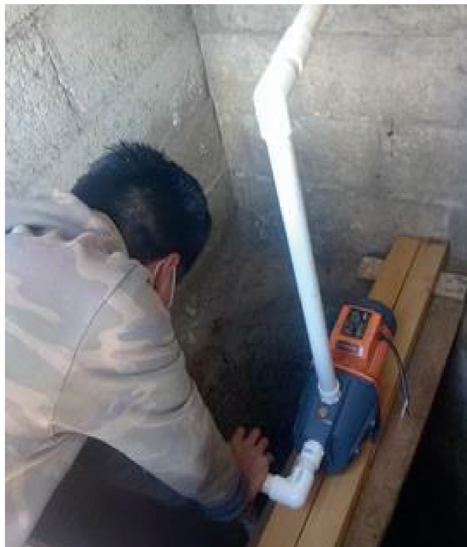
Instalación bomba de agua en Cajolá Chiquito
