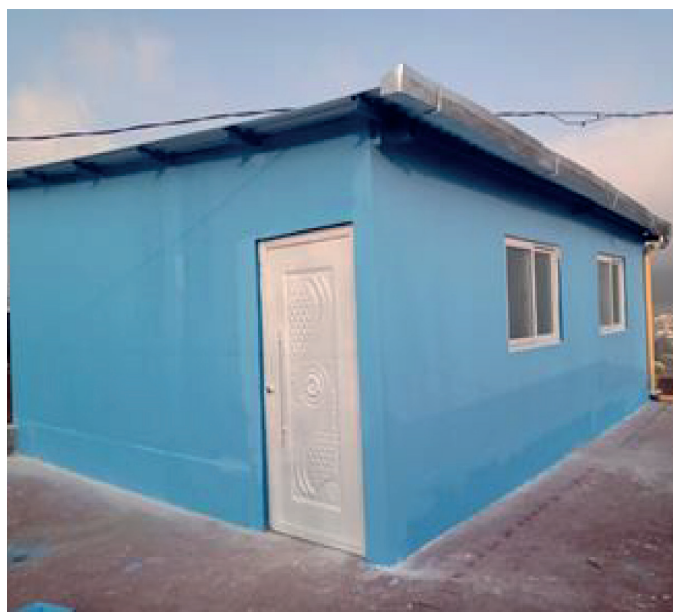
Construcción de salón de estructura metálica de 8x6 metros en C/S Cantel
